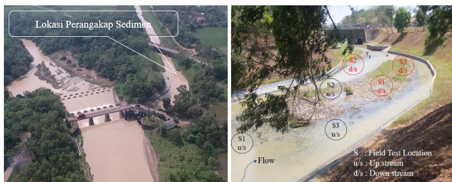
Gambar 2. Lokasi pengambilan bahan uji pada saluran dekat intake Bendung
