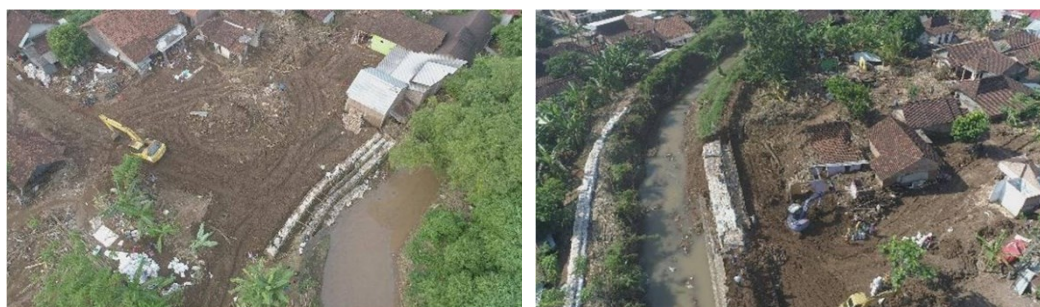
Gambar 6 Posisi Tanggul berada di tikungan luar
