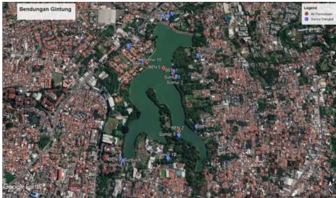
Gambar 2 Lokasi pengambilan air di Bendungan Situ Gintung
