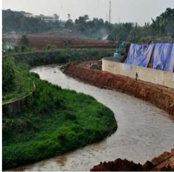
Gambar 5. Pekerjaan Perkuatan Tebing
