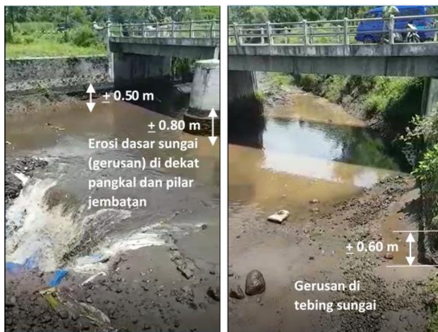
Gambar 6. Gerusan di sekitar jembatan di sebelah hulu Bendung Samberembe
