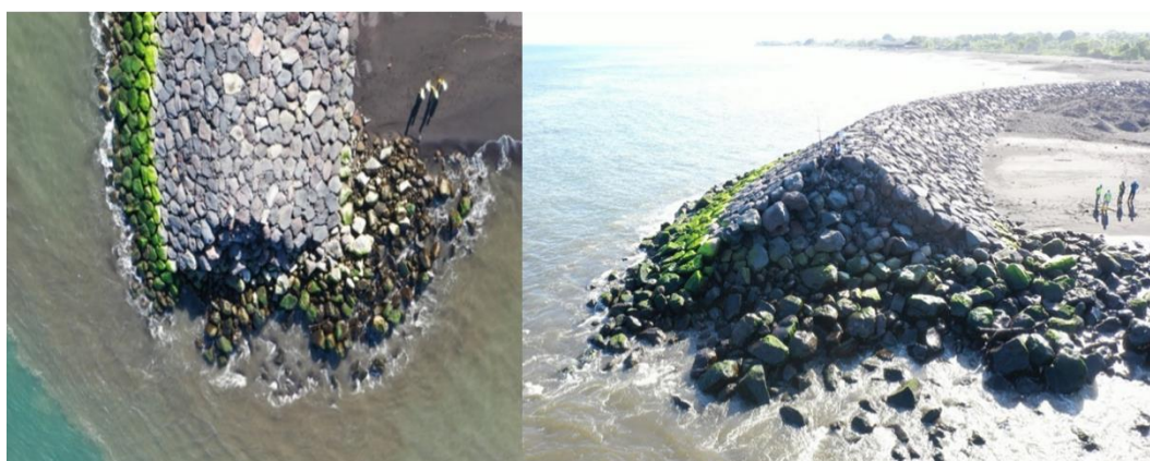
Gambar 1 Struktur Jetty Tukad Unda yang mengalami kerusakan
