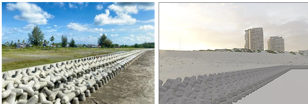
Gambar 15: Pemasangan dua lapis Tetrapod dan Pentapod
