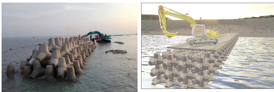
Gambar 16: Pemasangan Lebih dari dua lapis Tetrapod dan Pentapod
