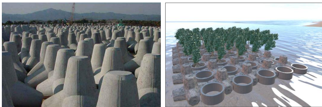
Gambar 14: Pemasangan satu lapis Tetrapod dan Pentapod yang longgar
