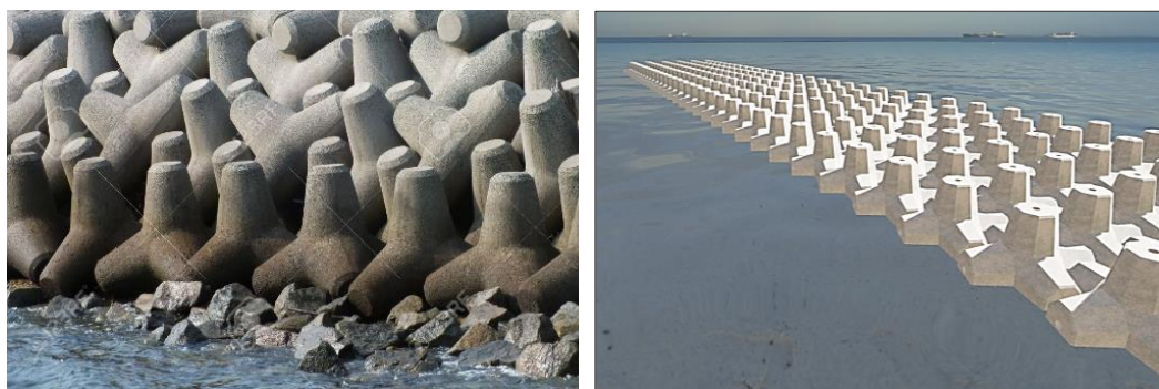
Gambar 13: Pemasangan rapat satu lapis Tetrapod dan Pentapod
