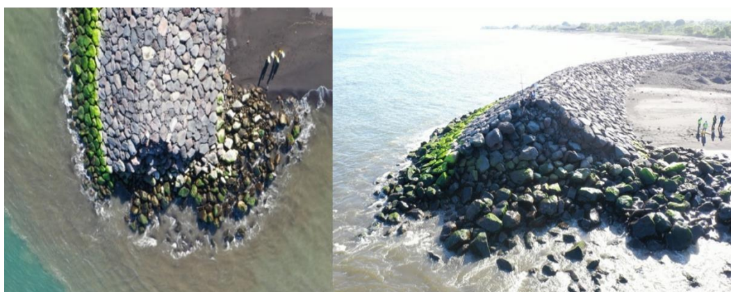
Gambar 1 Struktur Jetty Tukad Unda yang mengalami kerusakan
